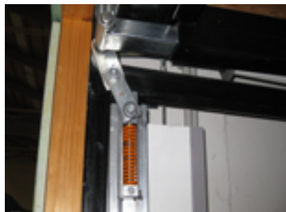
Besonders sicher und bei Toren neuer Bauart Pflicht ist die Abfangsicherung gegen mögliches Abstürzen des Torblattes.
