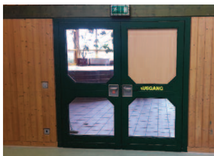
Abb. 1 u. 2: Unfallsituation – komplett zerstörte obere Türverglasung und Bruchbild der nicht sicheren Verglasung. Mit Sicherheitsglas wären die Verletzungsfolgen gering gewesen.
