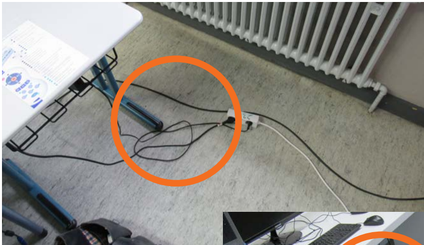
Abb. 3 und 4: „Kabelsalat“ in einem Klassenzimmer mit Gefahr der Quetschung des Kabels durch das Tischbein.
