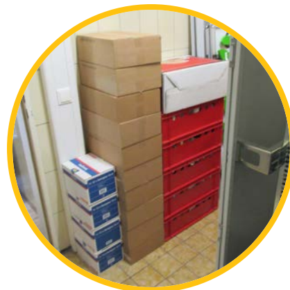
Abb. 1 und 2: Typische Situationen in Schulserverräumen; Kartonagen auf Server-schränken oder Nutzung als Lager-raum mit entsprechend erhöhter Brandanfälligkeit durch Kartonagen und Papier.
