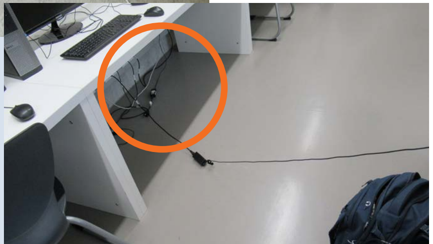
Abb. 3 und 4: „Kabelsalat“ in einem Klassenzimmer mit Gefahr der Quetschung des Kabels durch das Tischbein.
