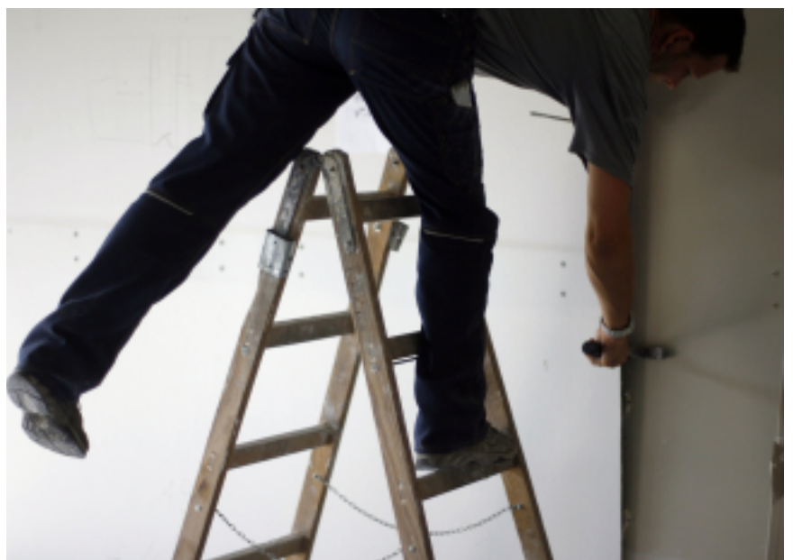
Abb. 1: Die Unfallsituation - Absturz von der falsch eingesetzten und nicht bestimmungsgemäß genutzten Leiter.
