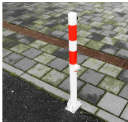
Schwenkbare bzw. absenkbare Sperrposten ermöglichen eine Befahrung nur in Absprache mit dem Hausmeister
